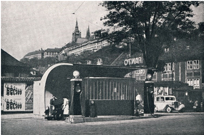
Fig. 13. Josef Gočár, Fanto gas station, Klárova Street, Praha – Malá Strana, 1930s. (Photo: Vyšehradské jezdec, 2020)
