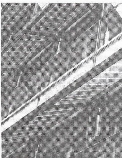
Budova spoločnosti SUVA, Bazilej, Švajčiarsko - detailný pohľad na otvorené okná novej fasády s izolačnými sklami s integrovanými prizmatickými panelmi a kontrolným mechanizmom
