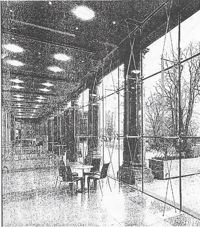
Obr. 1, 2, 3 Kultúrno-spoločenská hala vo Wuppertale – sklená stena v interiéri (1), detail upevnenia izolačného skla (2), rez sklenou konštrukciou s lankovým vystužením (3)
