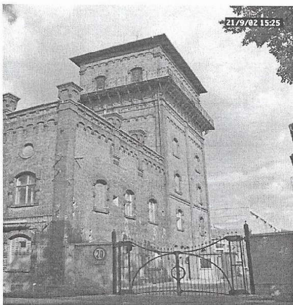
Foto 3. Masná Brno – vodárenská věž areálu
