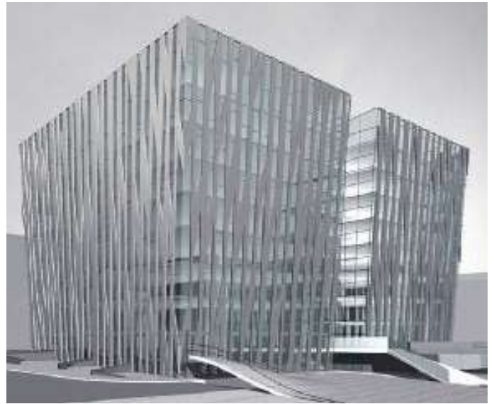
:: Polyfunkčná budova. Kollárovo námestie v Bratislave.
