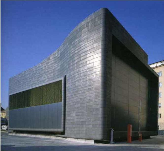
:: Trafostanica v Innsbrucku.
