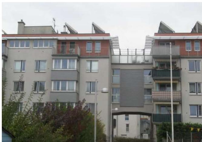
Obr. 18 Príklad riešenia optimalizácie plochy výplňových konštrukcií z hľadiska denného osvetlenia v kontexte s tepelnou stratou s maximálnym aktívnym využitím solárnej energie batériou solárnych strešných kolektorov – Komplex energeticky úsporných bytových domov vo Viedni.
