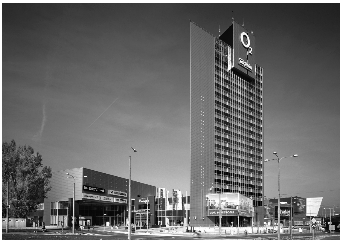
EUROPA CENTER Banská Bystrica – pohľad na areál z juhozápadu
