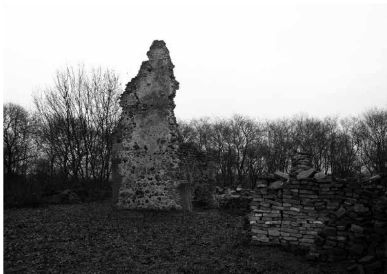
2 Pohľad na očistenú ruinu Pustého kostola vo Veľkej Čalomiji a slohová rekonštrukcia zaniknutej štítovej steny s anastylózou gotického lomeného portálu. Foto: Pavol Pauliny
