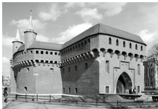
14 Slohová rekonštrukcia stredovekého barbakanu v Krakove, Poľsko
