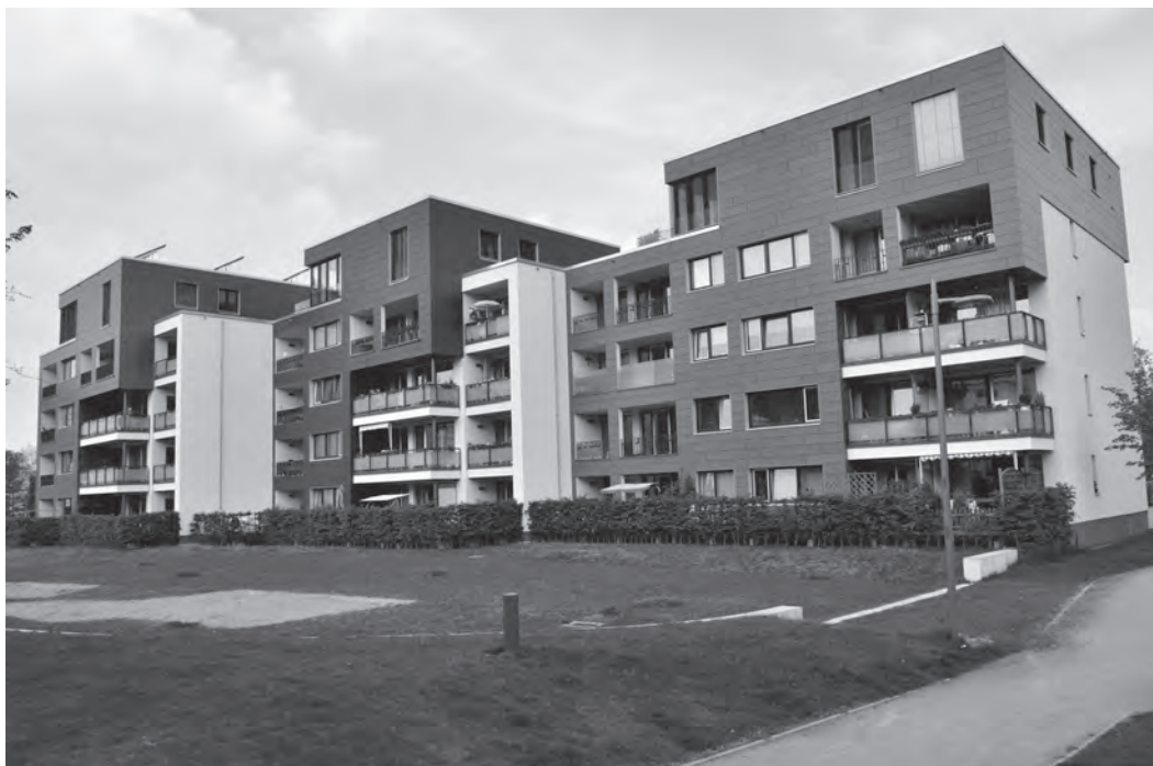
3 Prestavba panelových bytových domov na sídlisku Detmerode. Zdroj: Karol Görner
