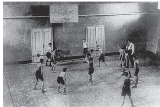
Bývalá telocvičňa, v súčasnosti A4 – nultý priestor. Zdroj: Ročenka 1933.
