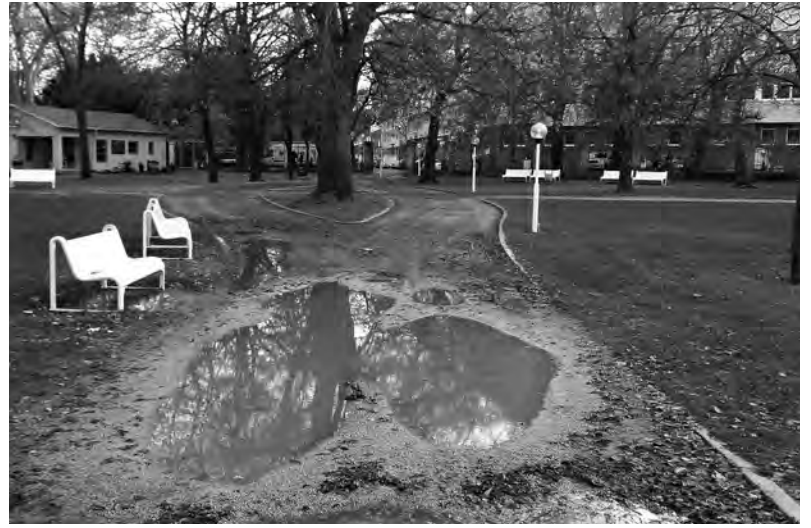
3 Vyjazdené priehlbiny zničených komunikácií sa v dôsledku zhutnenia plnia dažďovou vodou. Foto: Tamara Reháčková
