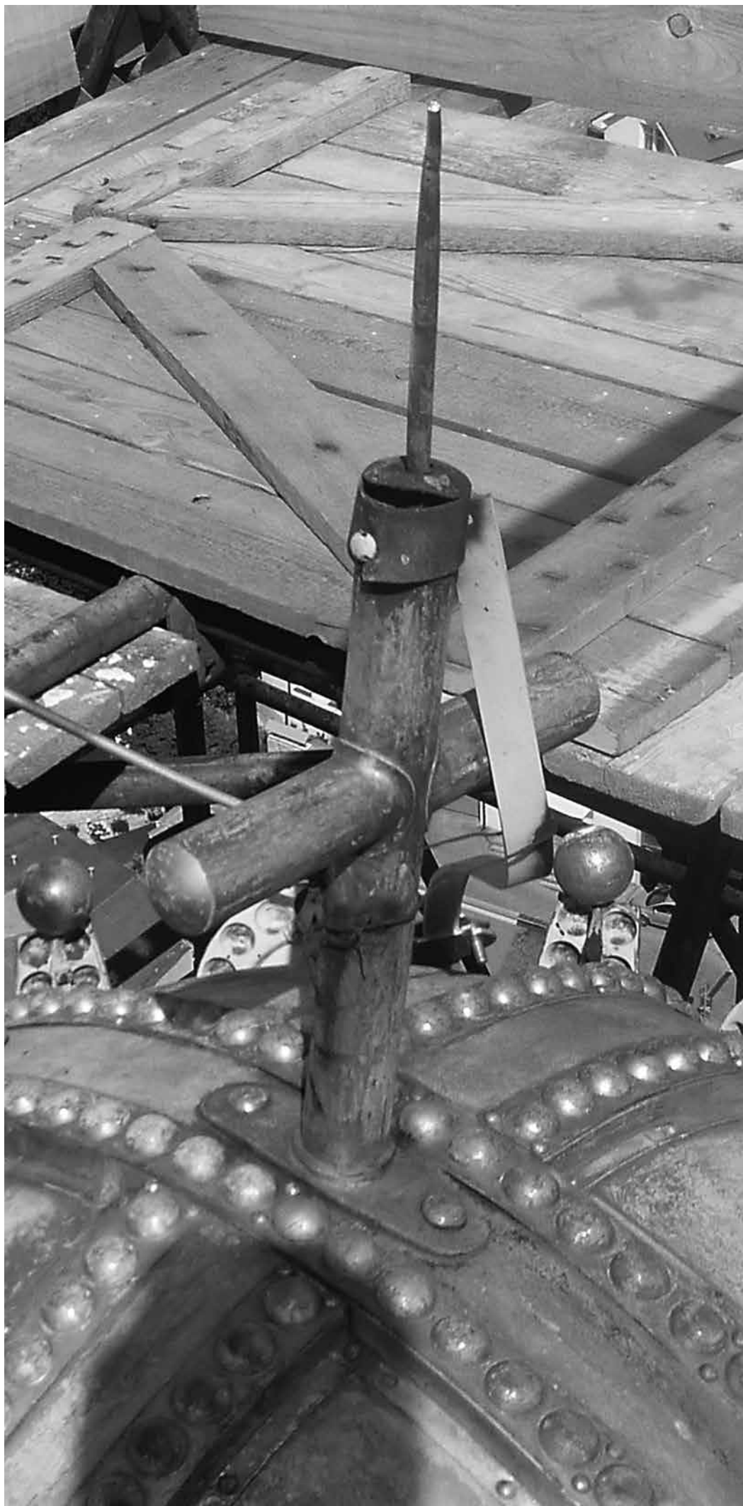
11 Detail dobového bleskozvodového zberača osadeného na krížiku zdobiacom model tzv. svätoštefanskej koruny. Foto: Patrik Baxa, 2010
