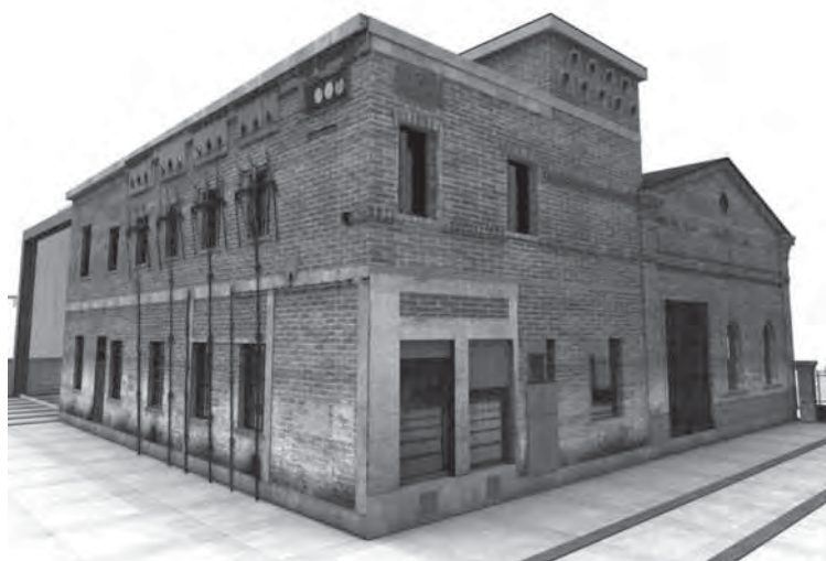
Variant s odstráneným dikoplastovým náterom so zachovaním všetkých prvkov ošetrovaných antikoročným náterom a novou zjednocujúcou tmavosivou farbou
