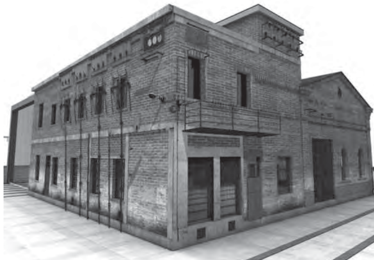
Variant s rekonštruovanými okennými otvormi so zachovaním všetkých prvkov ošetrovaných antikoročným náterom a novou zjednocujúcou tmavosivou farbou
