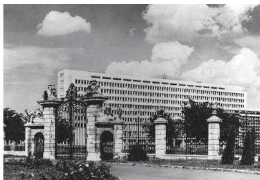
Ústredná poštová správa Zdroj: archív ÚSTARCH SAV
