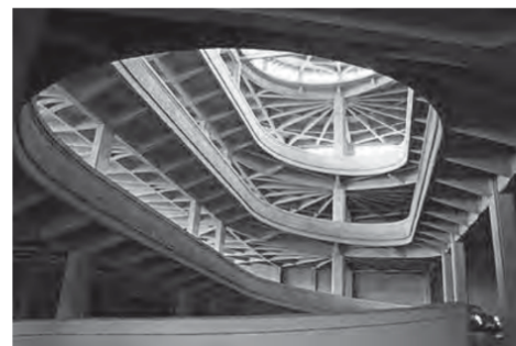
Továreň Fiat – Lingotto, rampa výstupu áut na skúšobnú pretekársku dráhu na streche objektu
