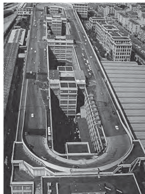
Továreň Fiat – Lingotto, strecha so skúšobnou dráhou
