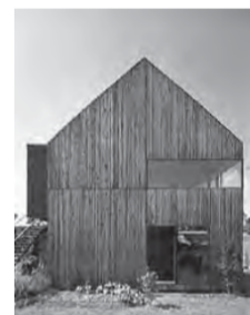
18 | Dom Wielandovcov má okná osadené pri vonkajšej ploche fasády Foto www.nextroom.at
