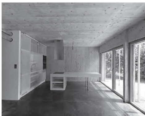
26 | Interiér domu v Bessancourt. Obytný priestor bez vykurovacích telies, vľavo hore sú viditeľné rozvody riadeného vetrania Foto Hervé Abbadie, www.karawitz.com
