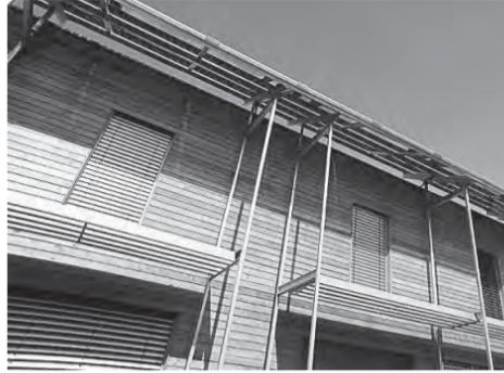
20 | Predsadená samonosná konštrukcia na radovom dome vo Weizi Foto www.erwin-kaltenegger.at
