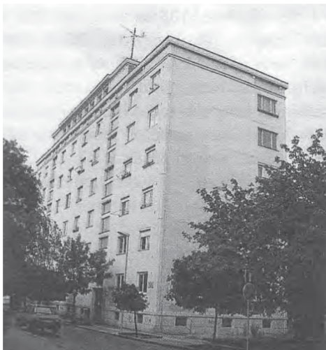
21 | Prvý panelový dom postavený v stavebnej sústave BA na Kmeťovom námestí v Bratislave 1955 (8) s. 17
