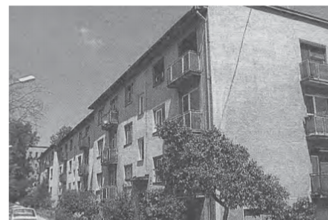
22 | Bytové domy Biely kríž v Bratislave 1946 (8) s. 15
