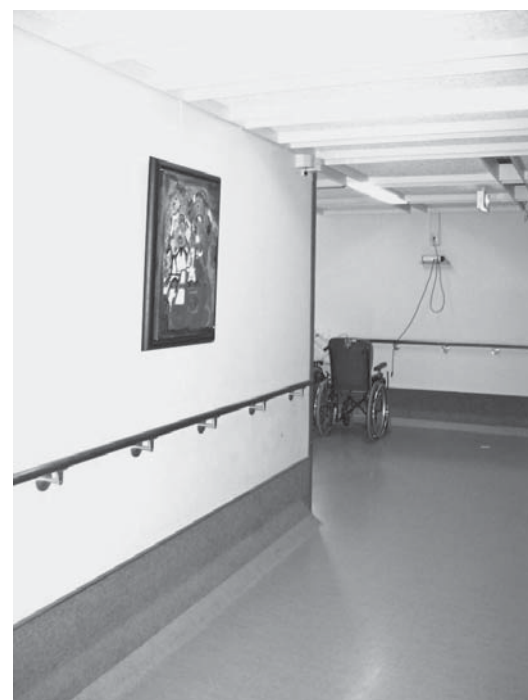
9 | Nemocničné prostredie chodbového priestoru vybavené madlom – Erasmus MC hospital v Rotterdame Foto: Stanislav Majcher
